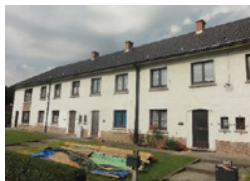
Rénovations toitures à Spy
