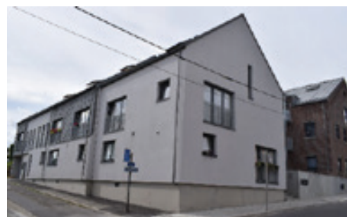
Rue du Comté à Auvélais
